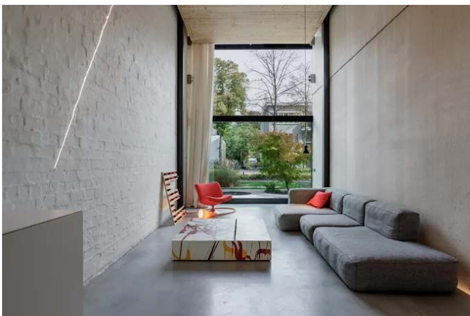
Het huis is recht tegen de zijgevel van de aangrenzende flats gebouwd, met enkel een kaleilaag. © ID/ Rhode Van Elsen
