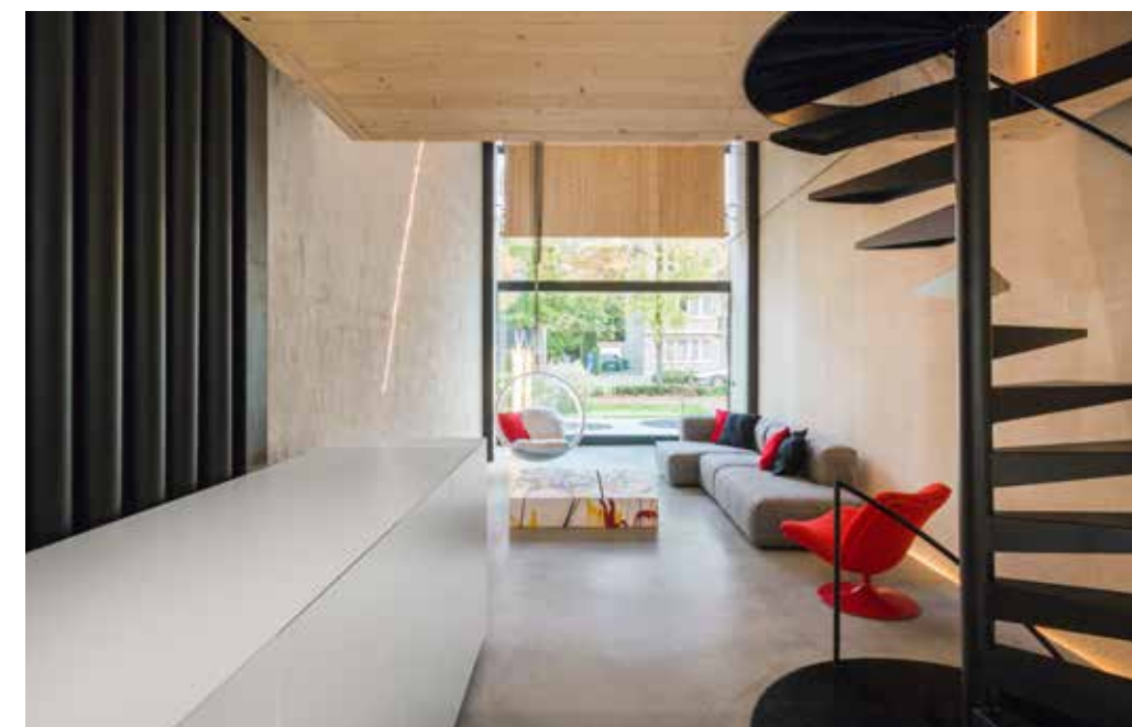
De dertien buizen tegen de wand in de keuken zijn behalve esthetisch ook praktisch: ze bevatten technieken zoals ventilatie, verwarming, elektriciteit en de dakafvoer.
