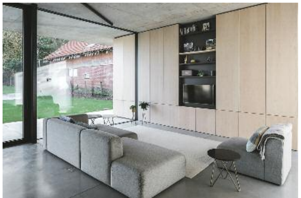
Het beton op de vloer (gepolierd) en dat aan het plafond (bekist met ruwe multiplex) zien er door de manier van afwerking helemaal anders uit. De zetel is van Hay.
