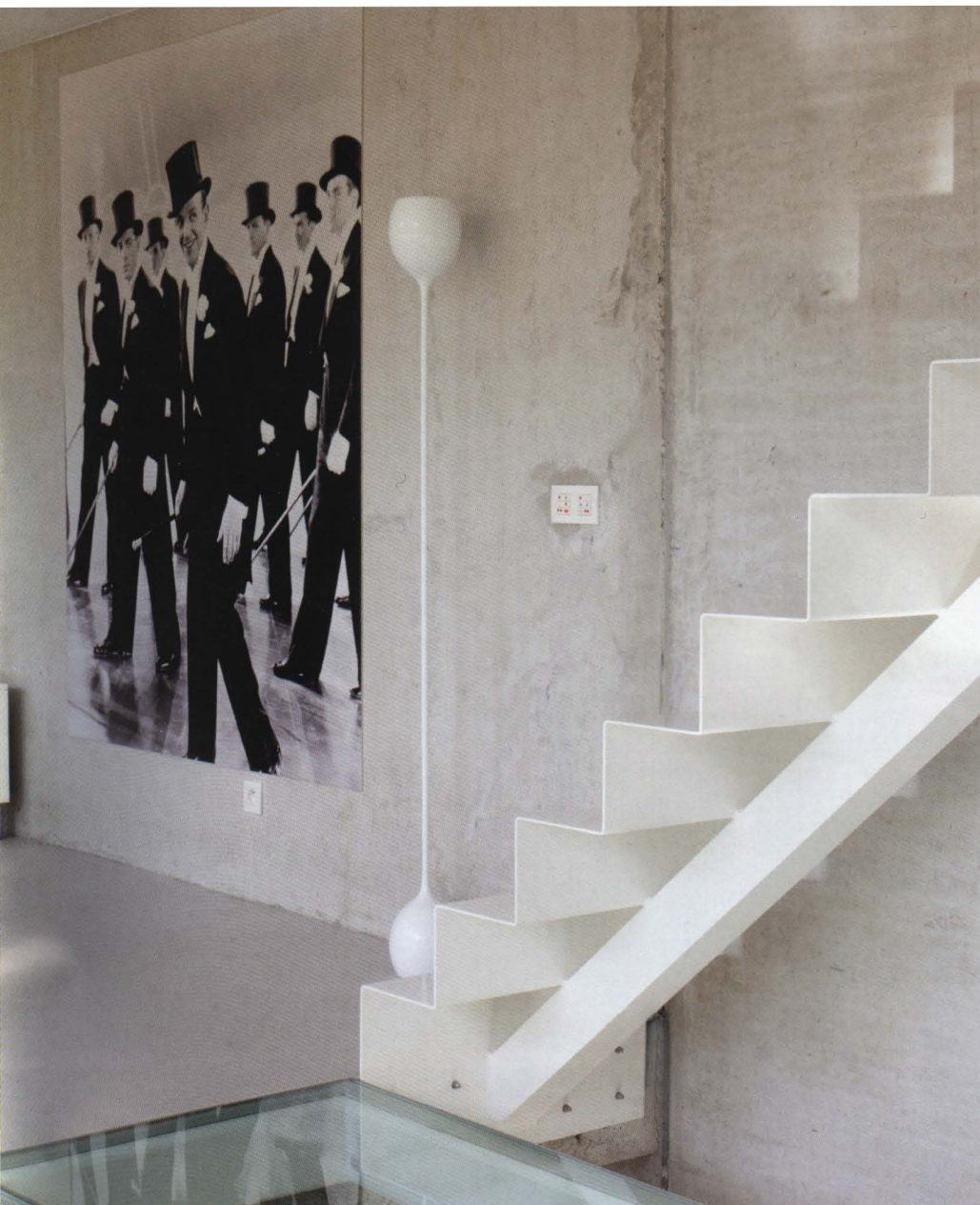
Boven: De trappen zijn gemaakt uit wit gelakte en geplooid aluminiumplaten.
