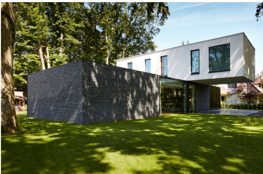
De ruwbouw werd verzorgd door Bouwbedrijf Artea. Van beneden zie je niet dat er zonnepanelen op het dak liggen, maar de woning is voorzien van de modernste (duurzame) technieken.
