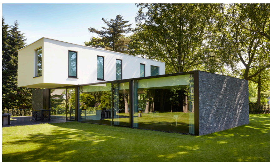
De vakmensen van L.A. Ramen Lanssens plaatsten het buitenschrijnwerk, dat zorgt voor het nodige contrast.
