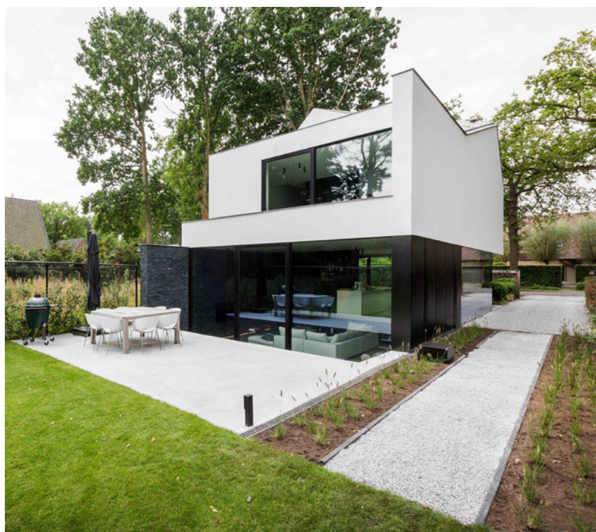
De witte gevel werd bepleisterd door G&V uit Bekkenvoort. Stabilos zorgde ervoor dat de woning stabiel is.
